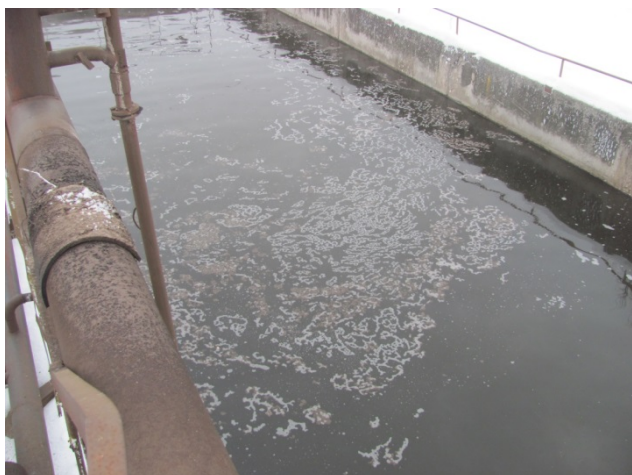
Рисунок 1.2.5 – Погибший ил на поверхности вторичного отстойника линии № 4
