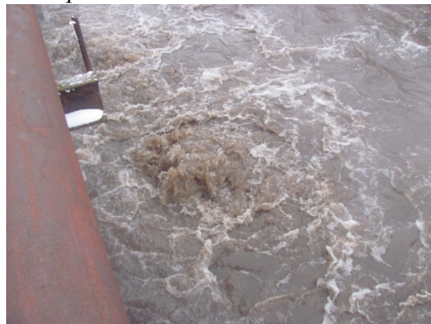
Рисунок 1.2.4 – Неравномерное поступление кислорода в аэротенк линии № 4
